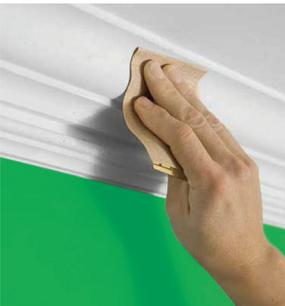
7. Для шлифовки поверхности используйте наждачную бумагу.
