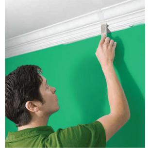
6. С помощью ножа для замазки швов обработайте стыки карнизов.
